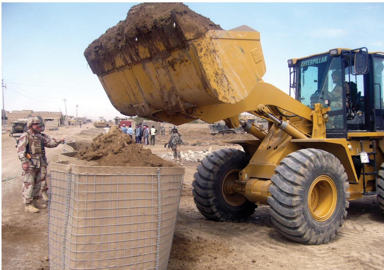
O enchimento mecanizado das células reduz o tempo de montagem das barreiras. (Andy Patton)
