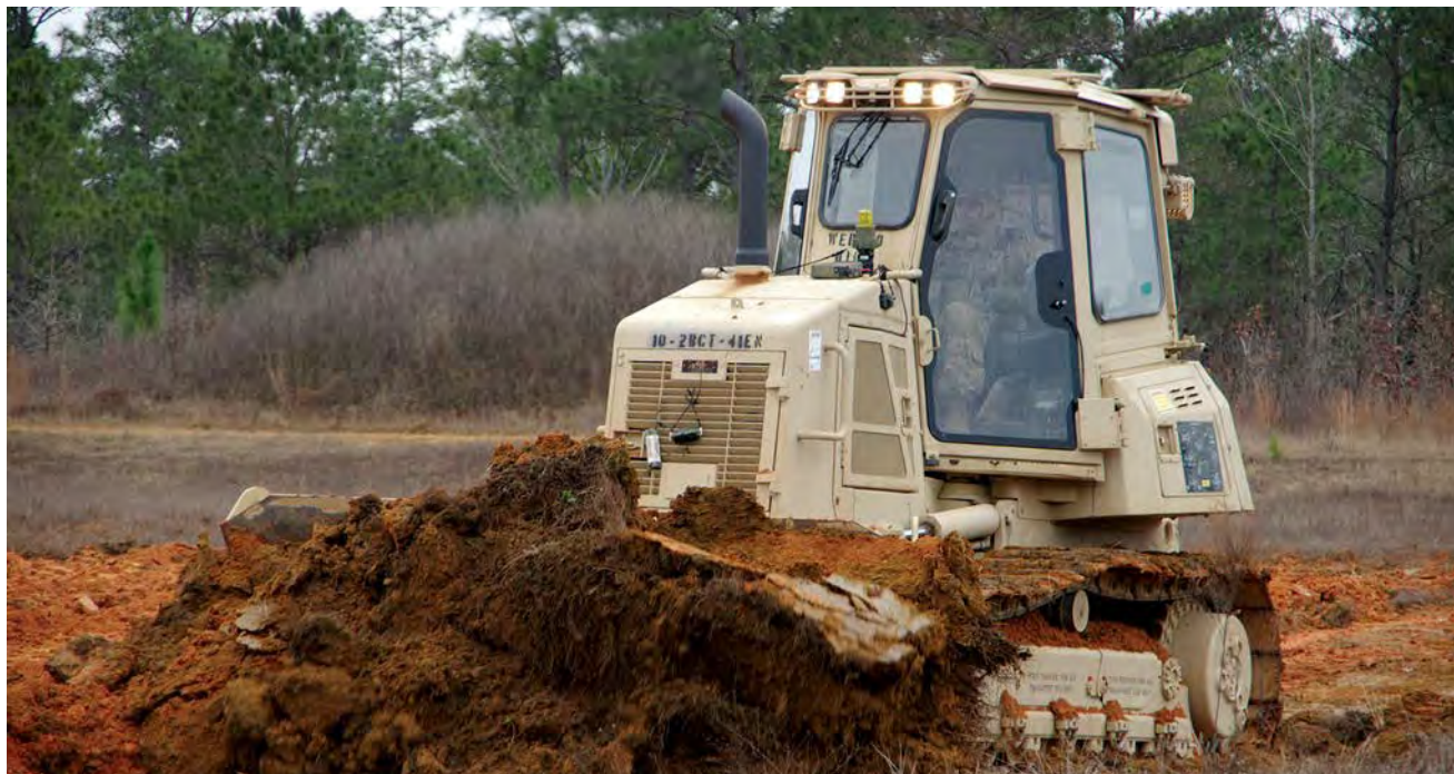
Engenheiros em apoio à 2ª BCT, 10ª Divisão de Montanha, constroem posições defensivas durante o exercício de adestramento no Centro de Adestramento e Aprestamento Conjunto (JRTC), em Fort Polk, Louisiana. (JRTC, Exército dos EUA)
