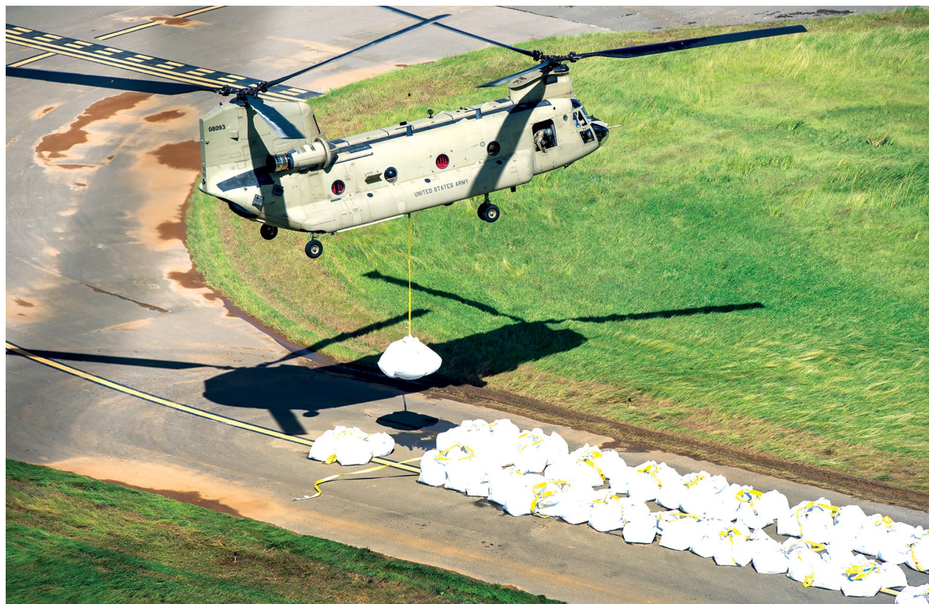
Um helicóptero CH-47 Chinook da Guarda Nacional transporta um grande saco de areia chamado de “supersaco” para colocação no vertedouro da represa Guajataca, 09 Out 17. O Corpo de Engenheiros do Exército dos EUA e a Guarda Nacional trabalharam em conjunto, a fim de estabilizar o vertedouro da represa após o dano causado pelo furacão Maria. (Sgt Mark Scovell, Exército dos EUA)
