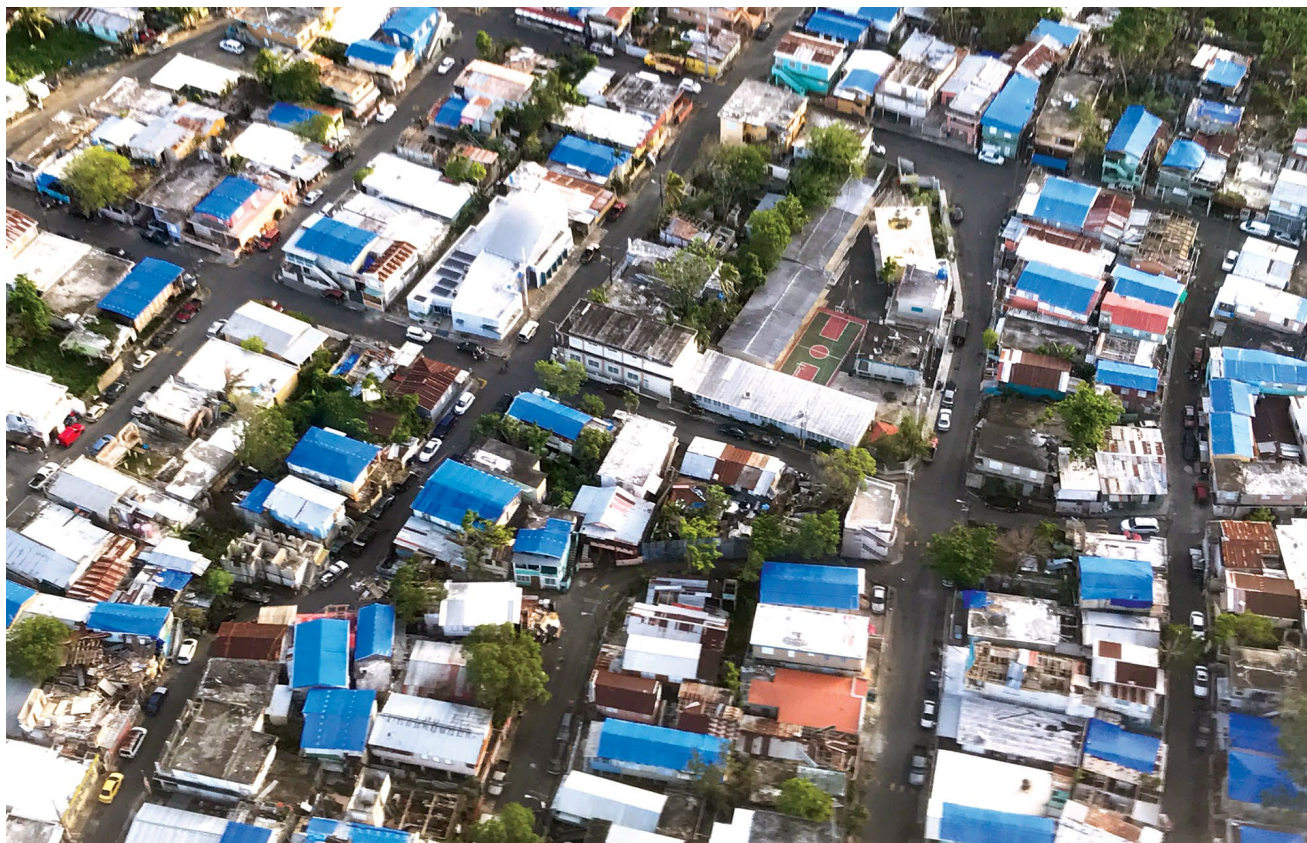
Quase 60 mil “tetos azuis” temporários foram instalados pelo Corpo de Engenheiros do Exército dos EUA em 2017 e 2018, após a passagem do furacão Maria. (Cortesia do autor)
