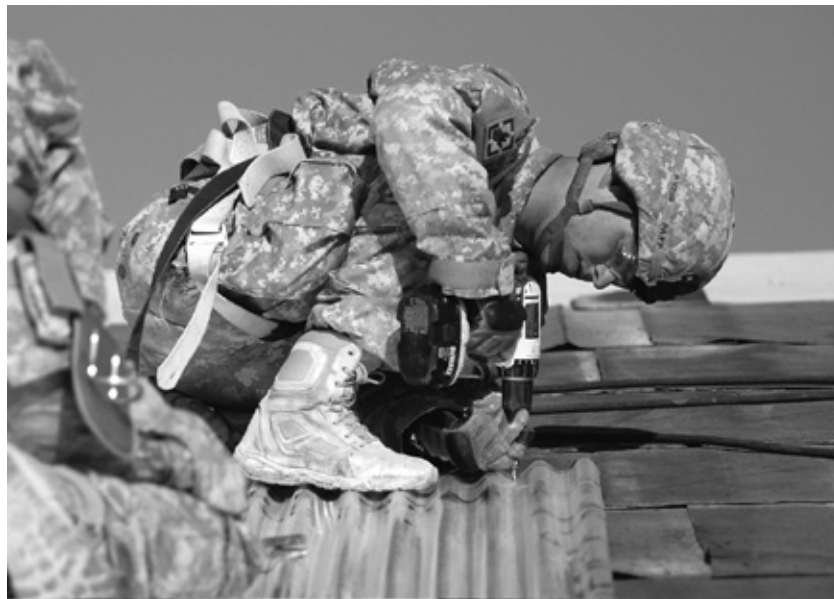
Cabo Michael Papp, do Exército dos EUA, designado para o 19º Batalhão de Engenharia, instala telhas de zinco durante obra no Campo de Aviação de Kandahar, Afeganistão, 14 de setembro de 2009.
