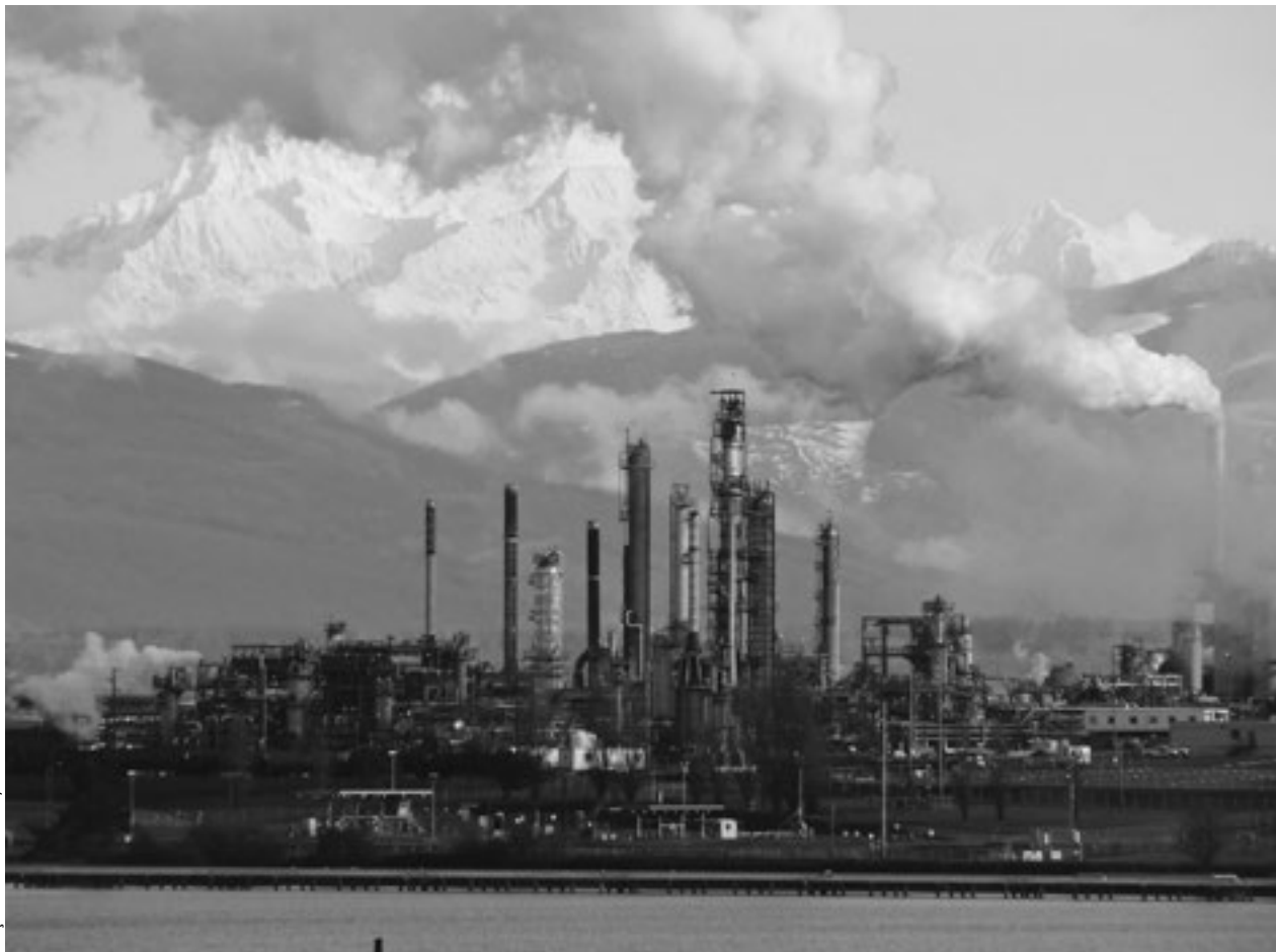
Refinaria de Petróleo de Anacortes, Estado de Washington.
