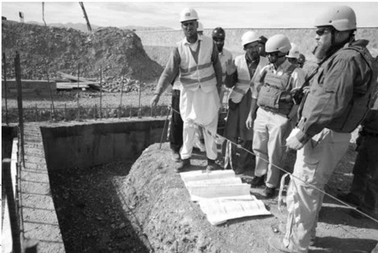
Integrantes da Equipe de Reconstrução Provincial de Paktia conduzem uma auditoria para a USAID no canteiro de obras de um hospital em Gardez, Província de Paktia, Afeganistão, 02 Nov 10.
