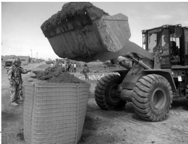
O enchimento mecanizado das células reduz o tempo de montagem das barreiras.
