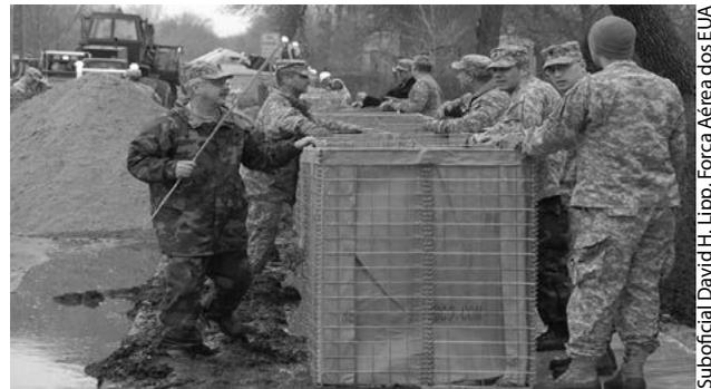
Após a montagem, as células são interligadas, formando barreiras de proteção.
