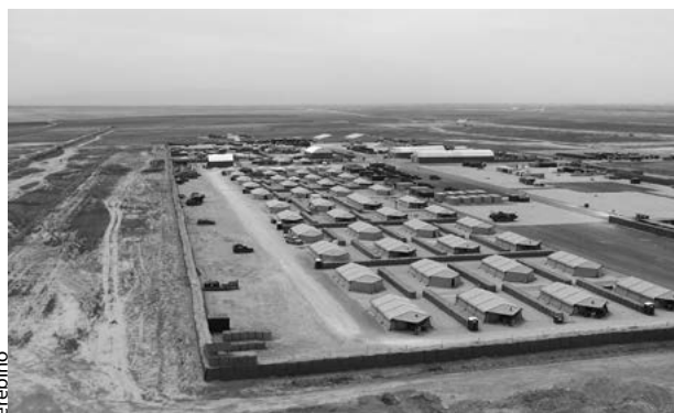
Emprego da concertainer na proteção do acampamento das tropas alemãs no Afeganistão.
