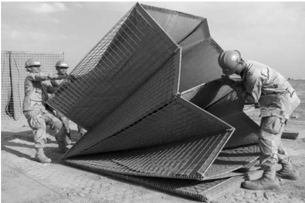
A montagem das células da concertainer é feita facilmente por três militares.
