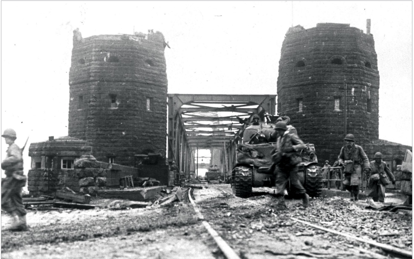
Carros de combate dos EUA atravessam a ponte Ludendorff, em Remagen, na Alemanha, em 07 Mar 45. A ponte fora preparada para destruição, mas ainda estava intacta quando o 27º Batalhão de Infantaria Blindada chegou ao local. Ao reconhecer a importância da ponte, o batalhão agiu por conta própria, mudando sua missão e capturando-a apenas 10 minutos antes da hora marcada para a detonação dos explosivos instalados pelas forças alemãs em retirada. A façanha permitiu que seis divisões cruzassem a ponte e continuassem a ofensiva a leste do rio Reno, antes do seu desmoronamento em 17 Mar 45. (Foto por 12/Alamy Stock Photo)
