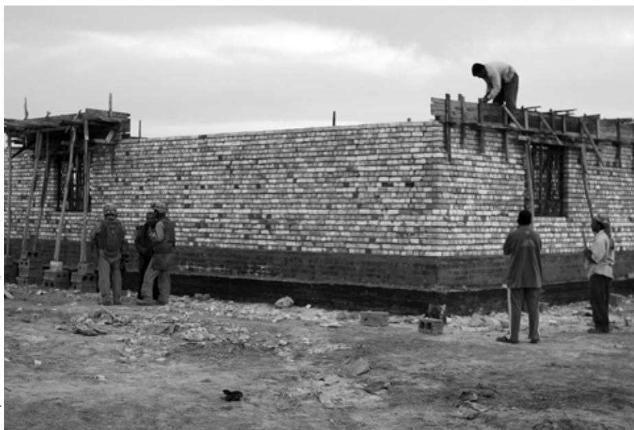
Obreros iraquíes construyen una nueva estación policial en Zaidon, Irak, 19 de noviembre de 2007.
