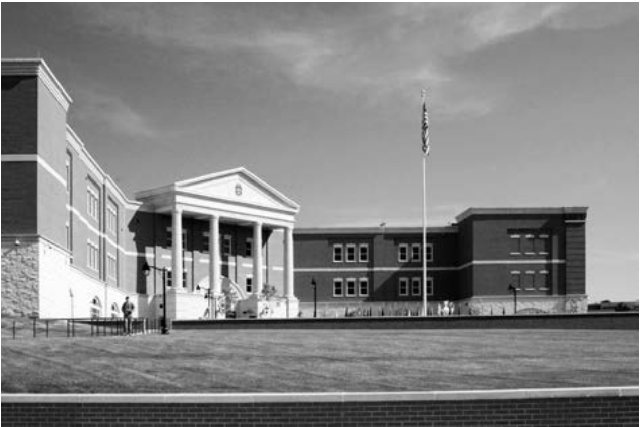
La fachada del edificio Lewis y Clark, sede de la CGSC, en el Fuerte Leavenworth, Kansas.
