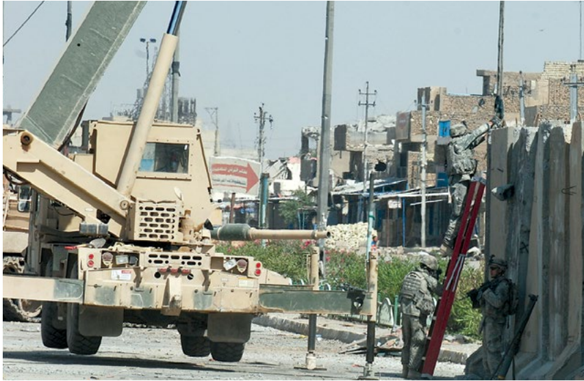
Soldados desmontan barreras de concreto, también conocidas como «Paredes T», de una grúa durante una iniciativa para mejorar la seguridad en la parte sur del distrito de Ciudad Sadr, Bagdad, 3 de mayo de 2008. (Foto: Ejército de EUA)
