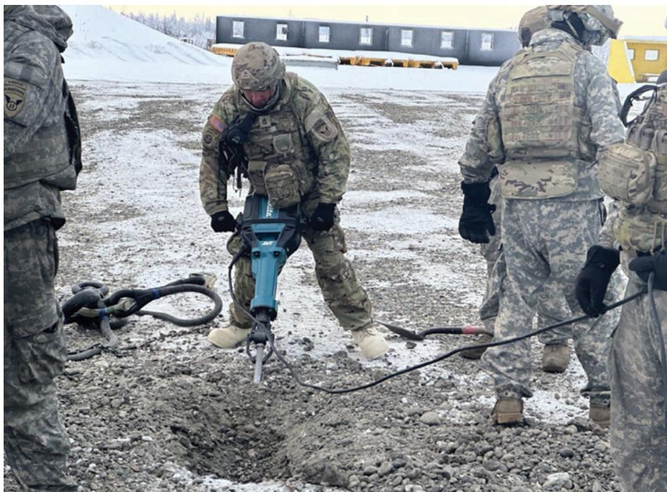
Soldados del 2.º Batallón del 8.º Regimiento de Artillería de Campaña utilizando un martillo neumático para romper el suelo congelado en preparación para el emplazamiento de un obús M777A2. Herramientas eléctricas como ésta aumentan la velocidad de emplazamiento de tres horas a menos de quince minutos. (Foto: Tte. Cnel. Chad Fitzgerald, Ejército de EUA)
